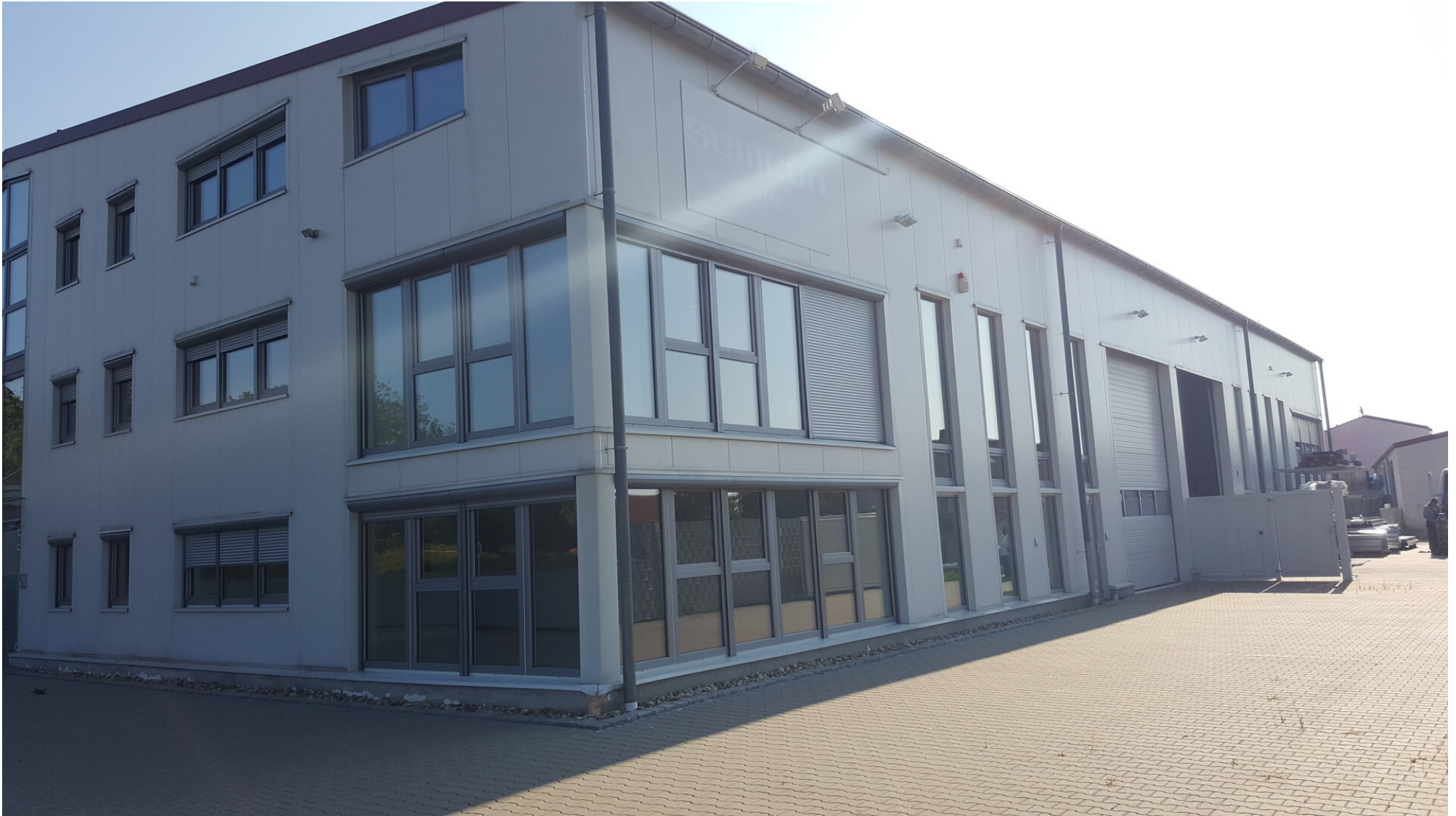
BI-25-02_SW 10-Westseite Halle
